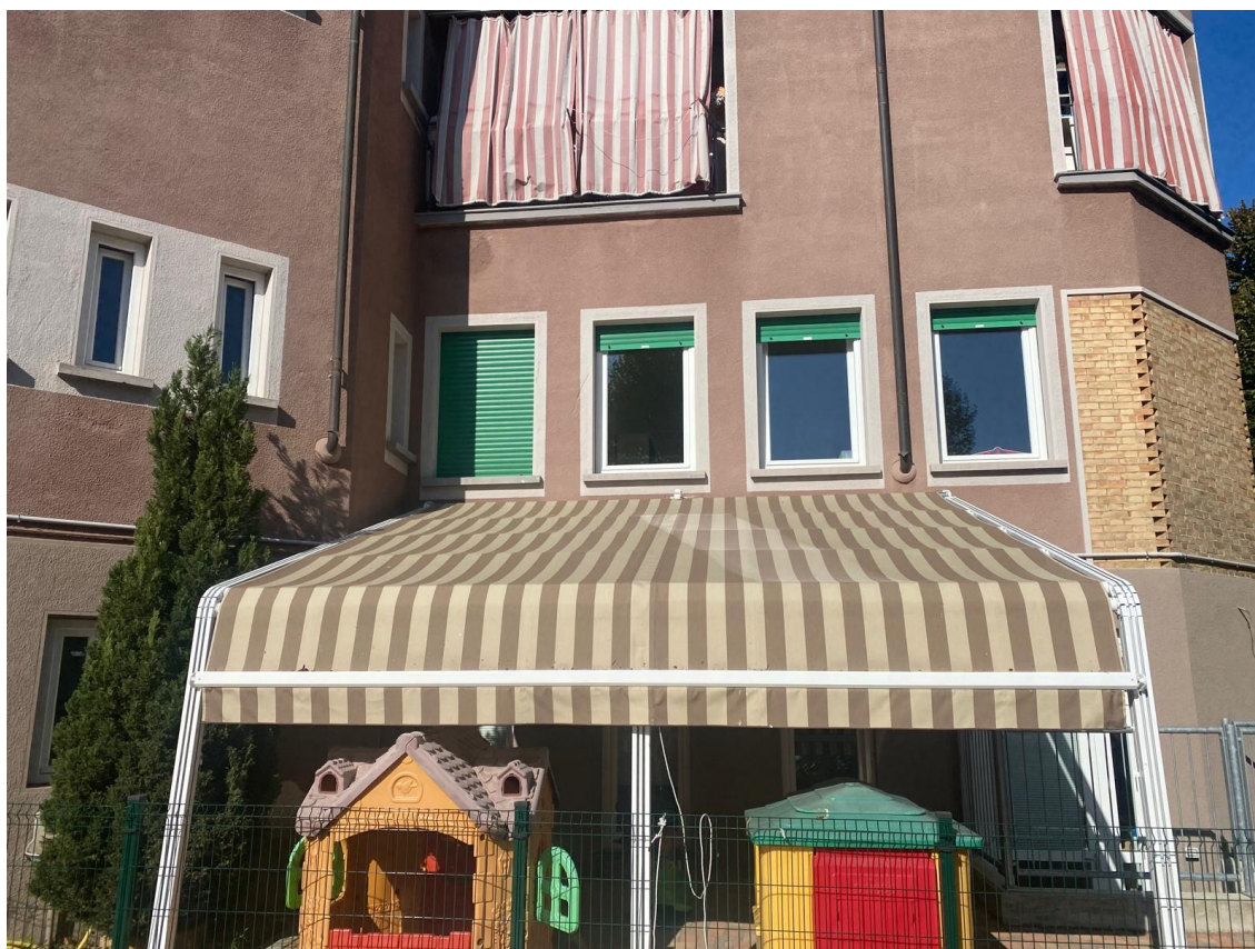
Acquisto e installazione tendone parasole per giardino esterno
